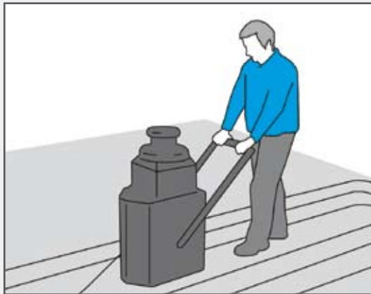
Einfräsen der Nuten für die Heizleitungen.
