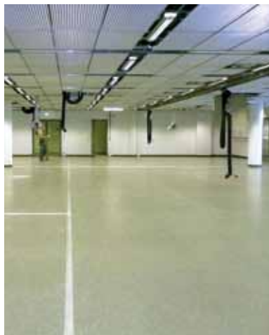
Auch das BMW Forschungs- und Innovationszentrum (FIZ) setzt auf GIFAfloor FHBultra von Knauf Integral. The BMW research and innovation centre (FIZ) also relies on GIFAfloor FHBultra from Knauf Integral.
